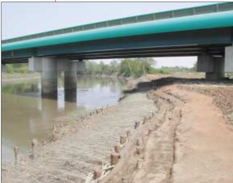
L'Ingénierie réalise des missions en génie écologique : ici la restauration des berges de l'Isle sur l'A 89.
