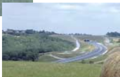
Tranchée couverte de sol de Roques sur l'autoroute A20
