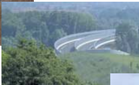
Tranchée couverte sur l'autoroute A14
