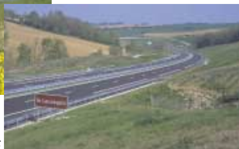
Insertion de l'autoroute A66
