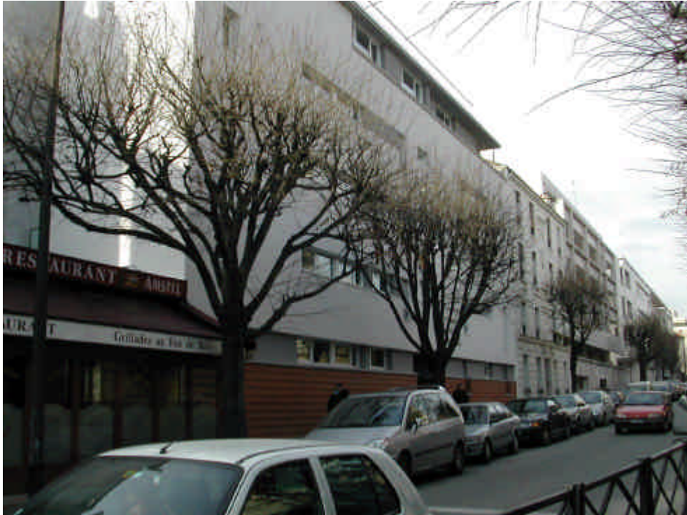
20 logements PLA réalisés par l'OPHLM de Montreuil, rue Pasteur Architecte : Emmanuelle Colboc
