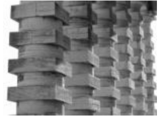
Figure 19 : Les colonnes de la maison du directeur – Salines d'Arc et Semans – C.V. Ledoux architecte.
