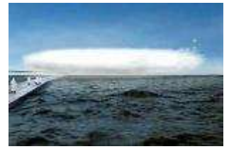
Figure 27 : Pavillon nuage – Expo02 – Suisse – 2002 – Diller & Scofidio architectes.
