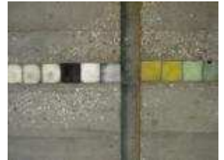
Figure 13: Détail d'un mur de la Fondation Querini-Stampalia – 1963. Carlo Scarpa architecte.
