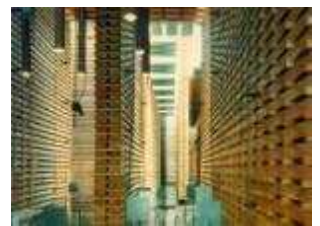
Figure 11 : Pavillon suisse – Exposition universelle – Hanovre 2000. Peter Zumthor architecte.
