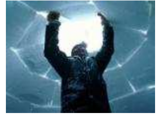
Figure 4 : Pose de la clef de voûte d'un igloo.
